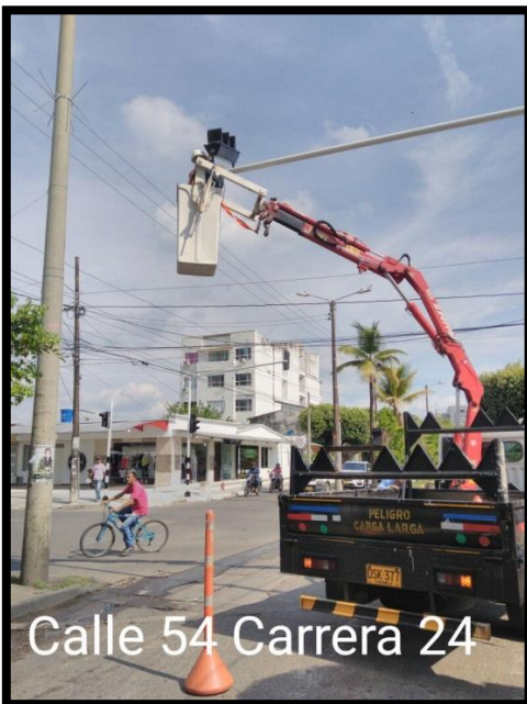
Cambio de módulo semáforo
