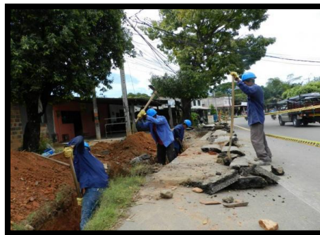
Construcción Alcantarillado Pluvial en el Barrio Altos de la Virgen en la Diagonal 60 del Municipio de Barrancabermeja
